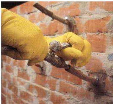
Način injektiranja zidanog zida
